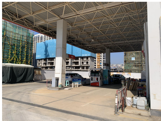
营业厅后，拟拆除的加气站
