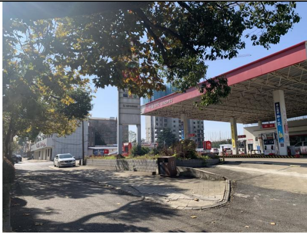
污水排放口未设置标识牌
