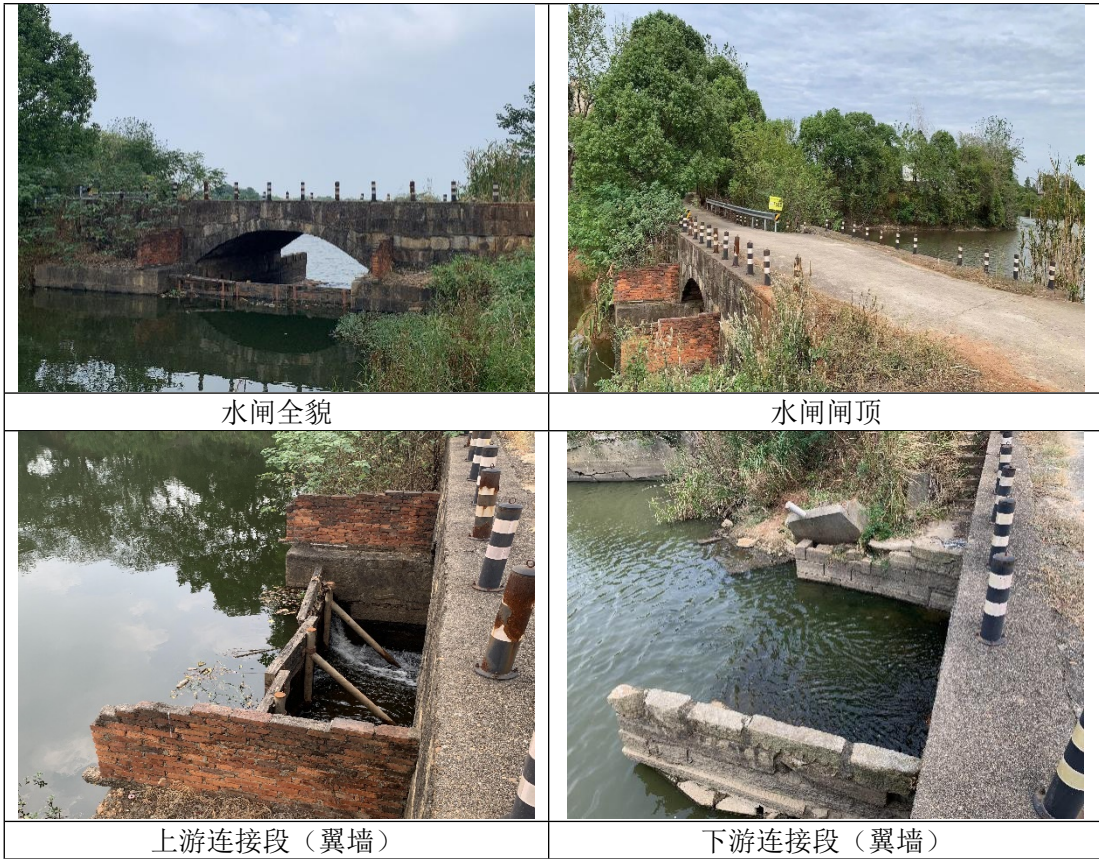
长沙市望城区小型水闸工程管理情况，见表2-1。
